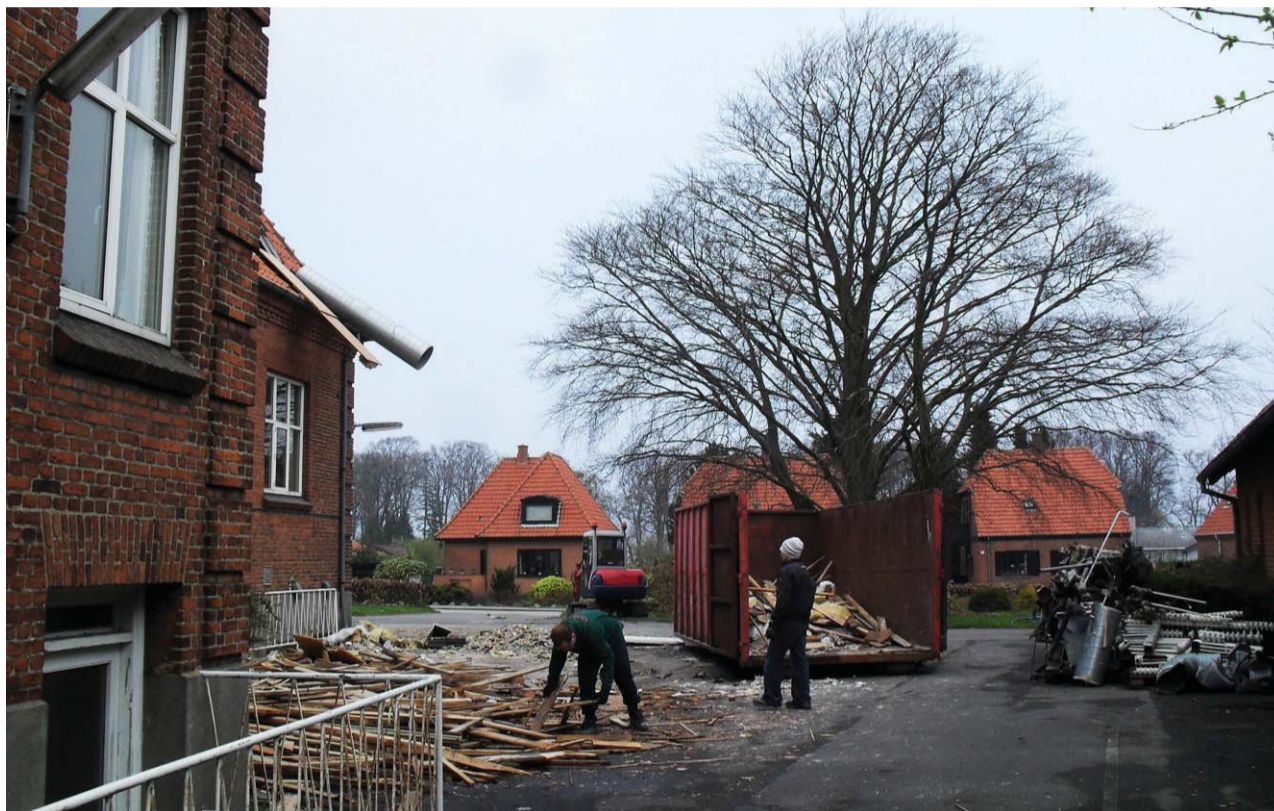
Renoveringen af det gamle sygehus i Stubbekøbing er i fuld gang. Her er Rasmus og Tommy i sving.
