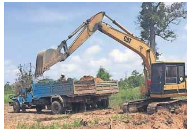
Gravemaskiner er i gang med at rydde plads til den nye skolebygning i Fjendeskoven.
